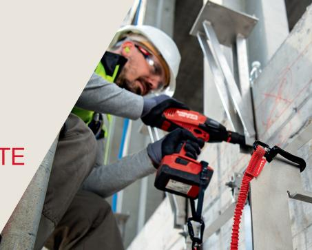
Dans le cadre des travaux de chantier, l'utilisation des attaches d'outils est un moyen simple et efficace de prévenir les blessures, et même d'éviter les accidents mortels, dus aux outils échappés.
