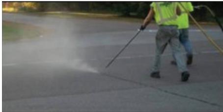
L'utilisation d'une machine à air comprimé peut aider à éliminer les particules de poussière du béton.
