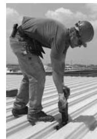
Outil de tôlerie pour pannes et solives composées minces et outil de fixation des recouvrements latéraux tablier à tablier (se reporter à la section 1.4 ou 1.5)
